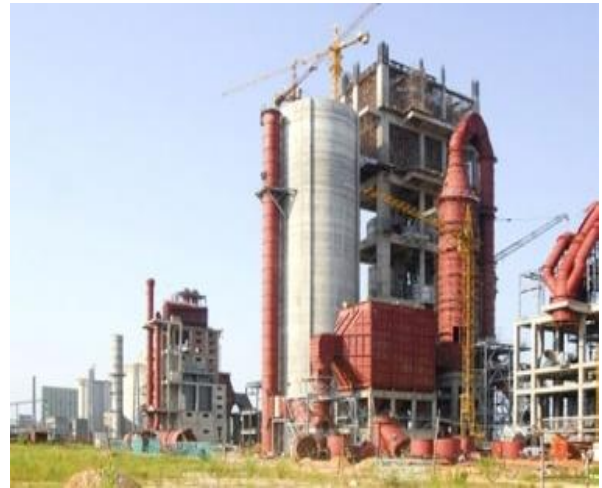
Một góc Nhà máy Xi măng Yên Bình
